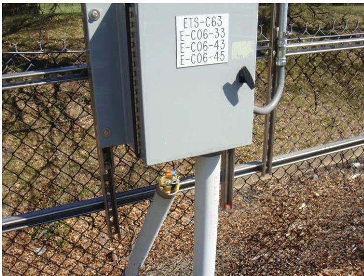
Figure 1 - C63 - Broken Conduit
